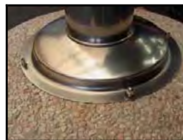
19 - Βιδώστε το περικόχλιο για να στερώσετε τη ντουζιέρα σφιχτά στη βάση
